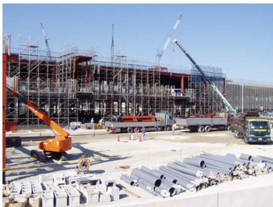
8164の整地工事現場の現状
