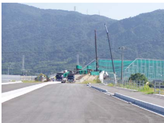
大江大橋の先、2号線へ繋がります
